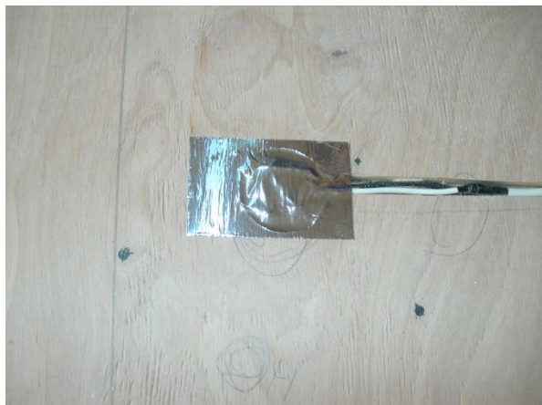
サーモスタットの溝配線施工例です。 ケーブルの太さに合わせた溝幅に加工してください。
