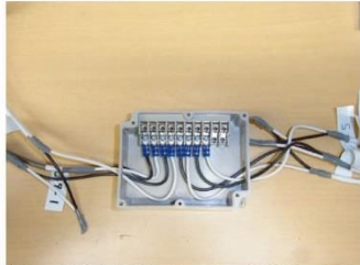
⑥ターミナルBOXにヒーター(7)とサーモスタット(7)を接続します。
