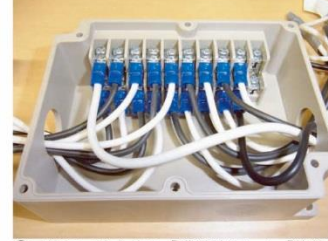
⑪最後に回路全体の「導通確認」と「絶縁抵抗測定」と「全体抵抗測定」を行い、適正であれば完成です。
