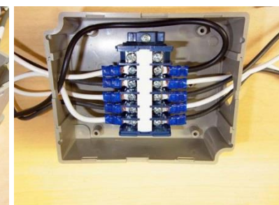
ターミナルBOX結線(回路構成)例
