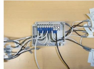
⑩ターミナルBOXに電源線(コントローラー出力側/負荷側)を接続します。
