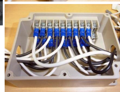
ターミナルBOX結線(回路構成)例
