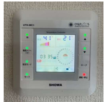
④通電を確認しコントローラーを操作
