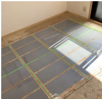
②ヒーターパネル(厚0.4mm)を敷く
