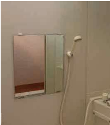
例① 4点で壁面設置
