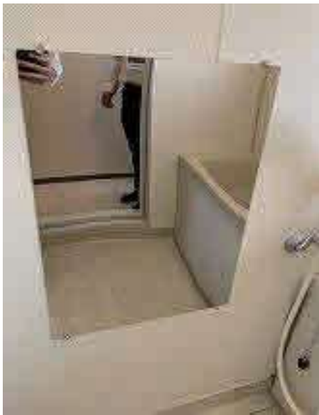
専用ビスでのビス留施工
